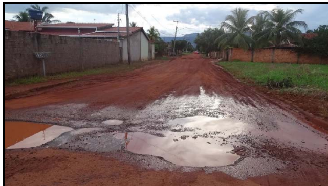
Foto 4 - Rua Jatobá (cruzamento com Av. Martimiano Ribeiro Fonseca) (Ponto de acúmulo de águas pluviais – necessita instalação de bocas de lobo para rede de drenagem)
